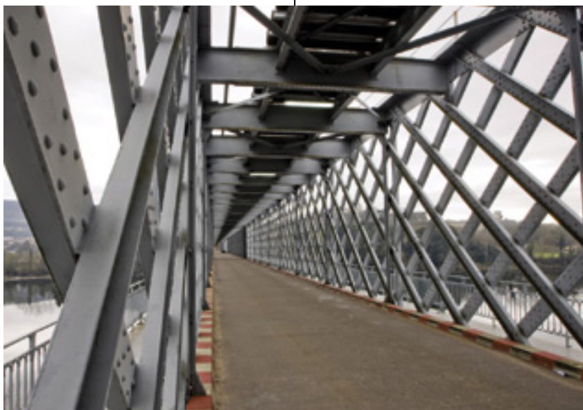
Ponte internacional Tui-Valença.
